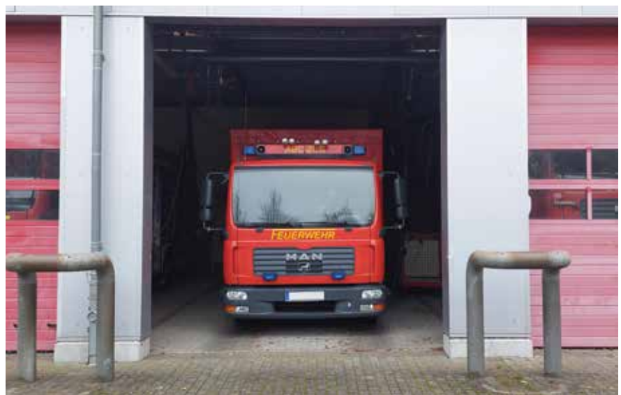
► Ausreichender Seitenabstand und Höhenabstand bei einem Stellplatz nach DIN 14092 Teil 1
